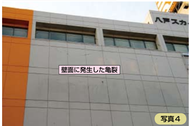
青森県八戸市 RC 建築亀裂例
