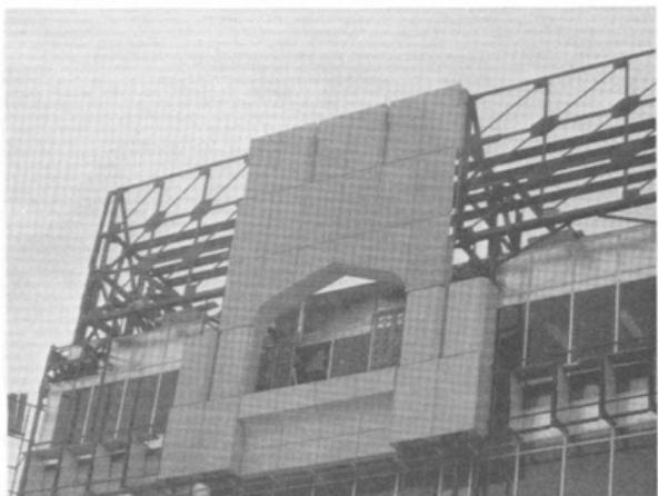
当初、契約段階でこの会社は、既存のコンクリートビルを囲む構造用フレームにGRCスタッドフレームパネルを取付けることによって問題を解決しようと提案した。パネルの形状、複雑さのため、この構造は最も適当な解決策と考えられた。
