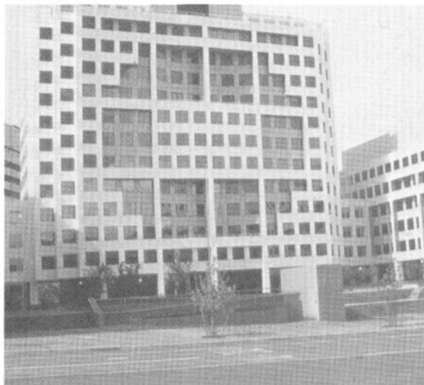
キャンベラ・コンベンション・センターは、約 22,000 m<sup>2</sup> の列柱を有するファサードから成っており、ビルの正面ではパネル位置を面外方向にいろいろ変えて、表面に凹凸をつけ、さらにパネルの色を変えて光と影の演出をさせた設計である。
