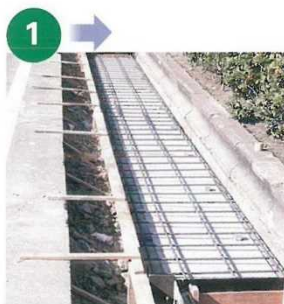
1 KCフォームの上に配筋した状態
