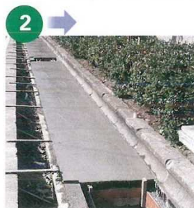
2 コンクリート打設
